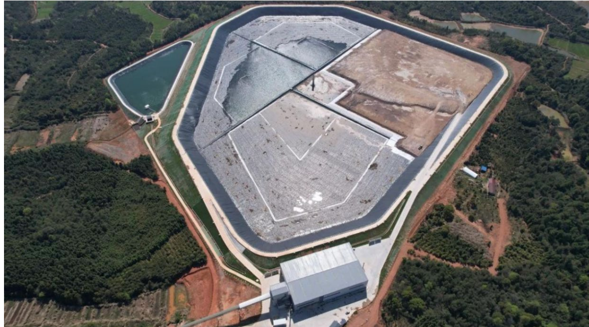
奉新时代浸出渣场
